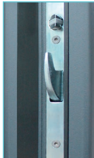
Crochet de sécurité et pêne à compression
